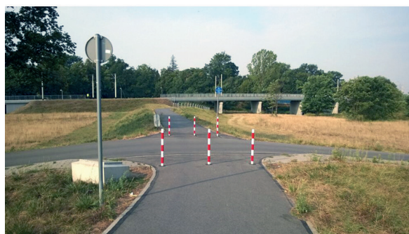
ZDJĘCIE 66z. Polska, Wrocław. Słupki blokujące na koronie wału z uchylnym słupkiem w osi trasy.
