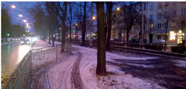
ZDJĘCIE 13. Polska, Wrocław. Brak poszerzenia i zbyt mały promień skrętu w ciągu drogi dla rowerów.
