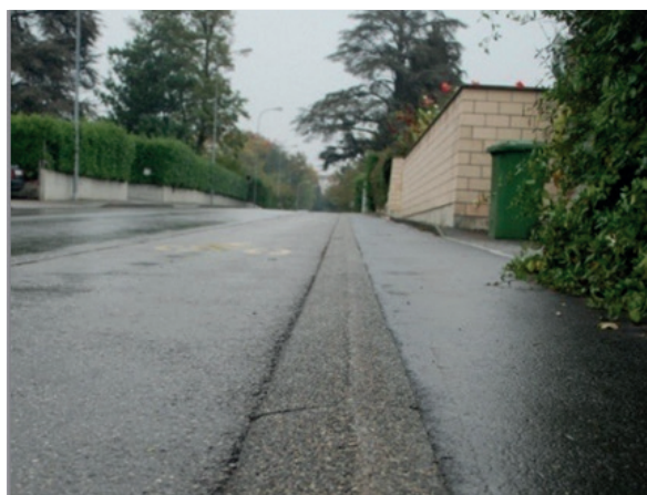
ZDJĘCIE 16. Szwajcaria, Genewa. Droga dla rowerów obniżona względem chodnika.
