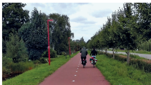
ZDJĘCIE 62. Holandia, Utrecht. Oświetlenie drogi dla rowerów.
