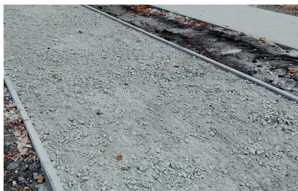
ZDJĘCIE 18. Wrocław. Podbudowa drogi dla rowerów.
