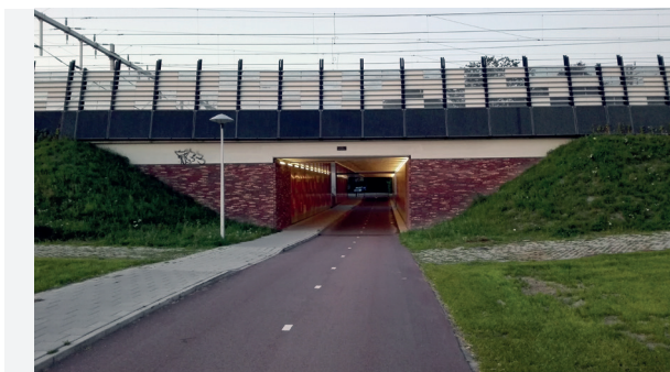
ZDJĘCIE 42. Holandia, Amsterdam, bezkolizyjne skrzyżowanie drogi dla rowerów z linią kolejową.
