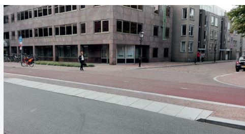
ZDJĘCIE 38. Holandia, Utrecht. Droga dla rowerów oraz chodnik przez wlot drogi podporządkowanej.
