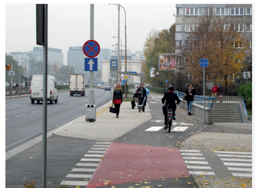
ZDJĘCIE 23. Wrocław. Oznakowanie drogi dla pieszych i rowerzystów.
