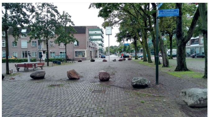
ZDJĘCIE 33. Holandia, Utrecht. Rozcięcie przelotowości ulicy.
