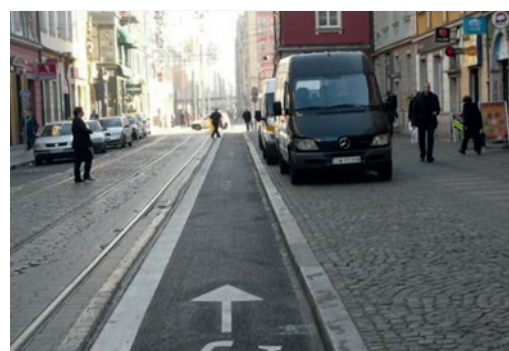
ZDJĘCIE 26. Polska, Wrocław. Asfaltowy kontrapas rowerowy na jezdni z kostki kamiennej.
