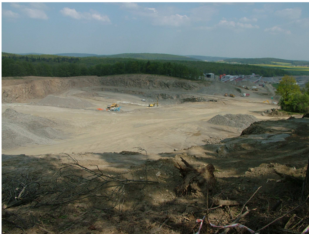
Fot. 1. Panorama kamieniołomu gabra i migmatytu oraz zakładu produkcji kruszywa na obrzeżach obszaru Natura 2000 „Wzgórza Niemczańskie” (widok od strony zachodniej). Fot.A.Wuczyński. Mimo konfliktowego położenia obiekt uzyskał zgodę na funkcjonowanie
