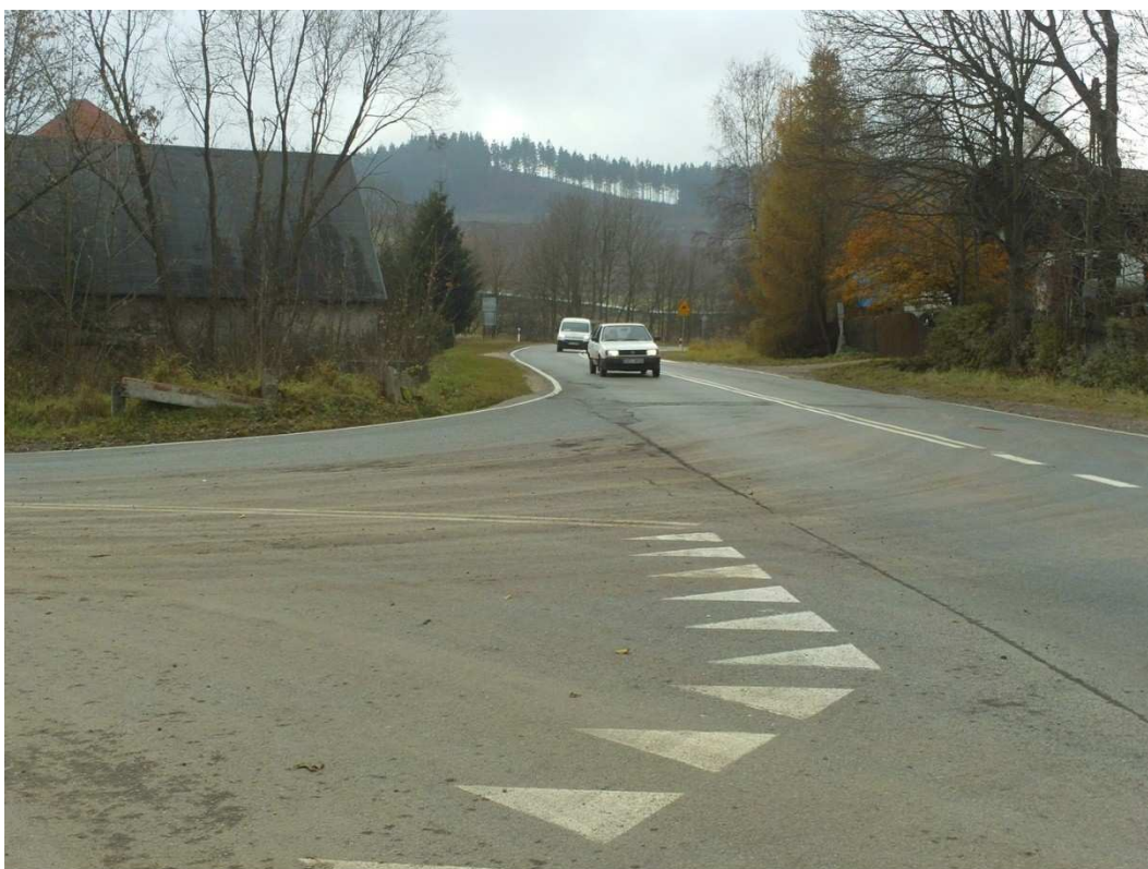
Rys. 2.48. Kopalnia melafiru Świerki - zjazd z drogi powiatowej nr 3338 na drogę wojewódzką nr 381 Kłodzko – Wałbrzych (fot. P. Komandowski, 2011)
