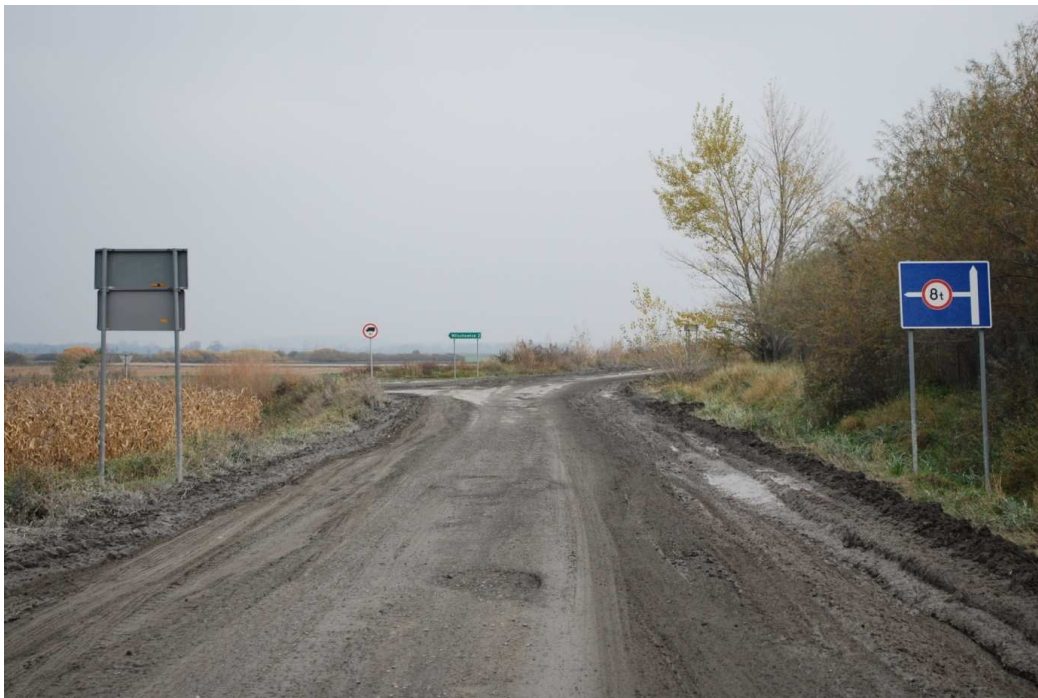
Rys. 2.43. Droga powiatowa nr 1986 Nasławice-Jordanów Śląski. Widok z wyjazdu kopalni serpentynitu Nasławice w kierunku skrzyżowania do Wilczkowic (fot. J. Blachowski, 2011)
