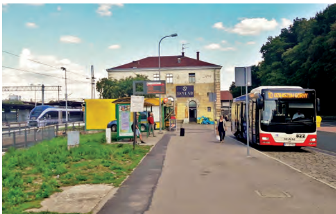
Fot. 2. Węzeł multimodalny w okolicy stacji kolejowej Jelenia Góra Autor fotografii: Michał Małysz.
