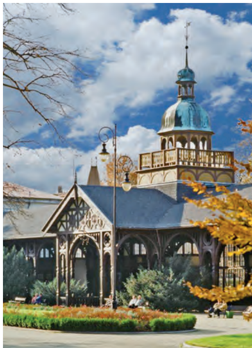
Fot. 1. Hala Spacerowa w Szczawnie-Zdroju
