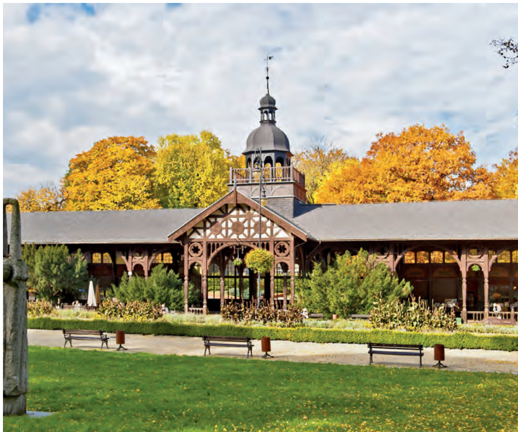
Fot. 1. Hala Spacerowa w Szczawnie-Zdroju
