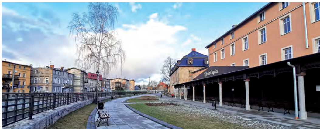
Fot. 4. Bulwar nad rzeką Kamienną z tężnią solankową po przebudowie – Cieplice-Zdrój / Bulvár nad řekou Kamienna se solankovou úpravnou po přestavbě – Cieplice-Zdrój
