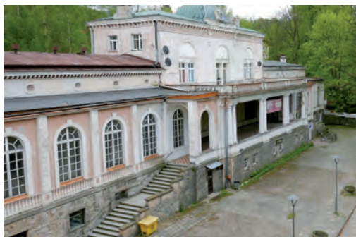
Il. 1. Stan obecny części głównej Domu Zdrojowego
