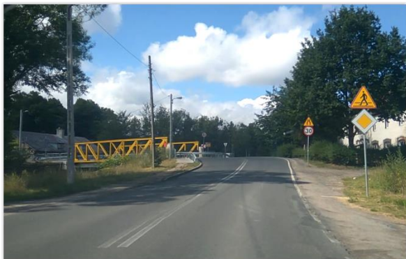
Fot. 25. Obiekt mostowy w Łomnicy
