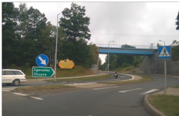
Fot. 15. Zjazd z ronda w Jeleniej Górze oraz wiadukt nad DK30
