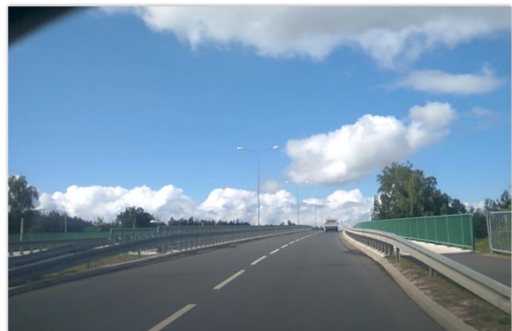
Fot. 24. Wiadukt nad ul. Łomnicką oraz torami kolejowymi
