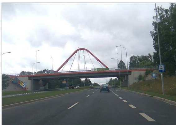
Fot. 5. Węzeł drogowy na 460+550 km
