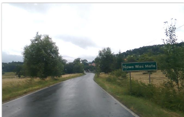
Fot. 29. Fragment drogi o dobrym stanie nawierzchni w Nowej Wsi Małej
