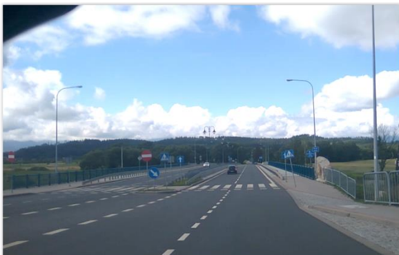
Fot. 23. Obiekt mostowy nad rzeką Bóbr
