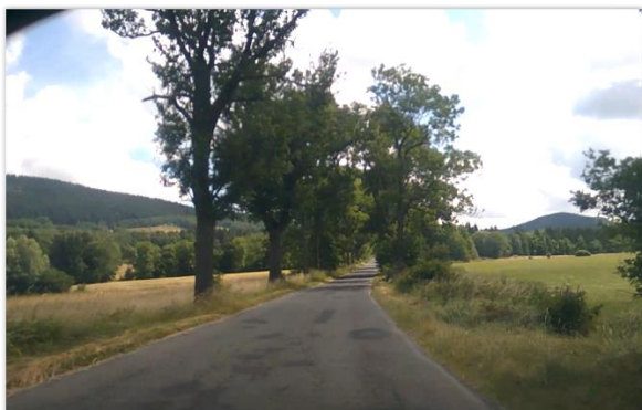
Fot. 27. Fragment analizowanej drogi za Kaczorowem
