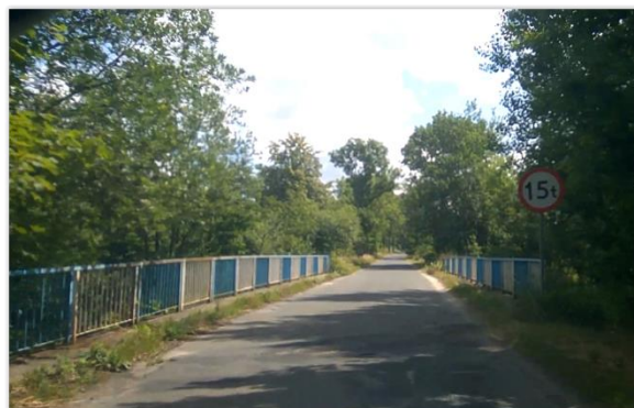
Fot. 28. Wiadukt nad koleją jednotorową
