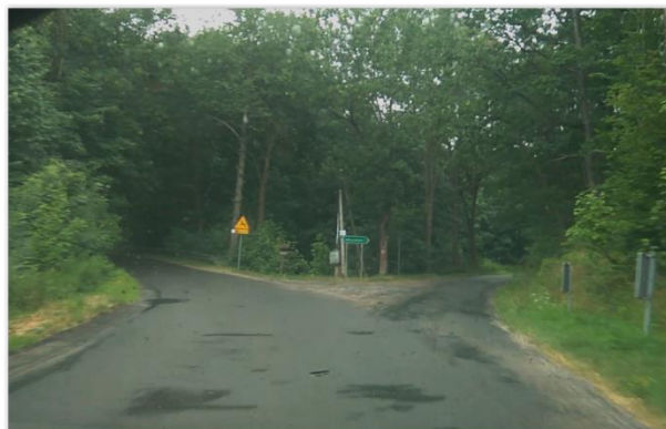
Fot. 32. Zjazd na drogę w stronę Jakuszowej
