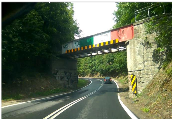
Fot. 1. Wiadukt kolejowy położony w ok. km 436+469
