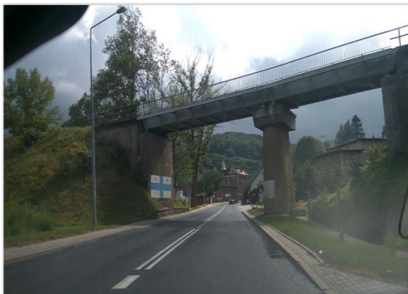
Fot. 3. Wiadukt kolejowy w ok. km 448+025
