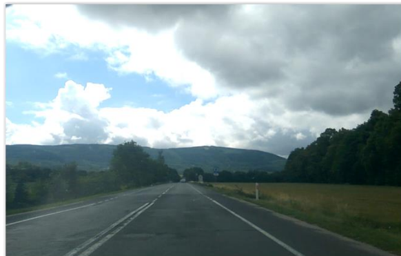
Fot. 26. Fragment drogi w stronę Kowar – szerokie pobocze i zły stan nawierzchni
