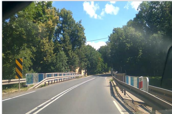
Fot. 12. Obiekt mostowy nad Nysą Szaloną w Wierzchosławicach
