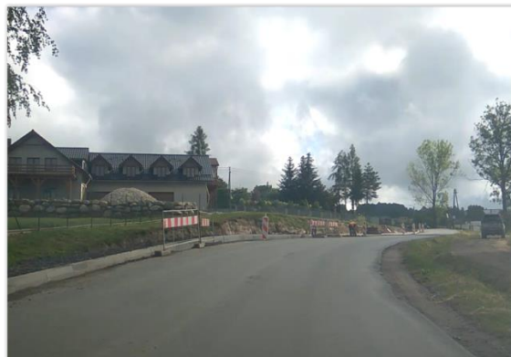
Fot. 20. Prace drogowe w miejscowości Dziwiszów
