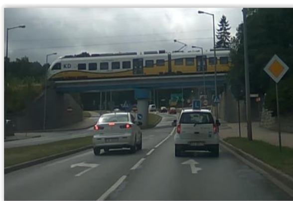
Fot. 6. Wiadukt kolejowy w Jeleniej Górze (466+820)
