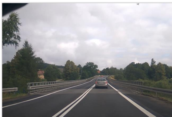
Fot. 18. Obiekt mostowy nad rzeką Kamienicą
