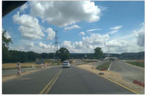
Fot. 14. Droga przy budowie drogi S3 w ok. Sadów Dolnych
