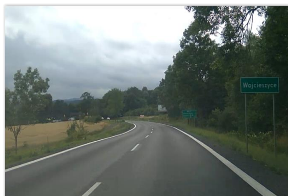
Fot. 8. Dobry stan techniczny drogi w Wojcieszycach
