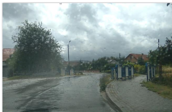
Fot. 30. Obiekt mostowy nad ciekim w Paszowicach
