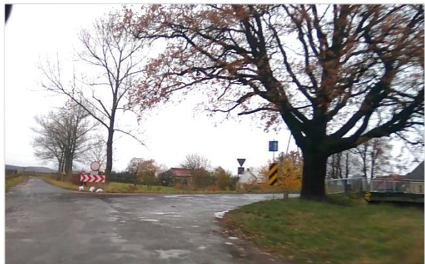
Fot. 58. Stan DP nr 2796D w rejonie budowanego węzła S3
