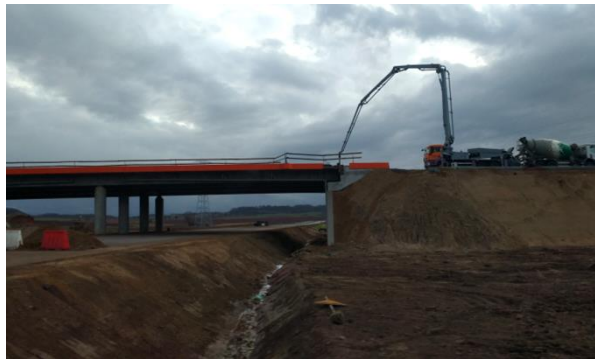
Fot. 18. Budowany węzeł S3 Bolków
