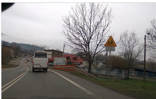
Fot. 45. Stan DW nr 367 w rejonie mostu nad Lesiem
