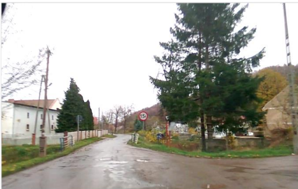
Fot. 57. Stan DP nr 2796D na moście w km ok. 002+460
