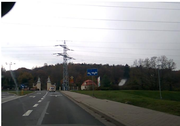
Fot. 9. Stan DK nr 34 w rejonie zmiany przekroju
