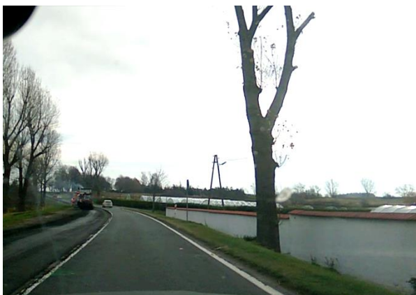
Fot. 6. Stan DK nr 34 na remontowanym odcinku
