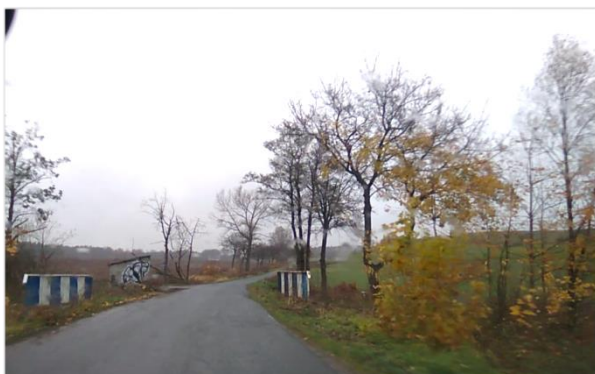
Fot. 51. Stan DP nr 2796D w rejonie ciek Sikorka
