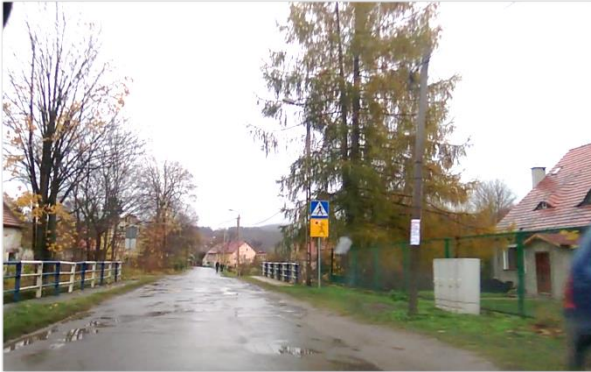
Fot. 55. Stan DP nr 2796D na moście w km ok. 003+850
