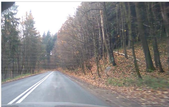
Fot. 37. Stan DW nr 367 na terenie gminy Boguszów-Gorce
