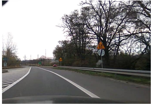
Fot. 20. Stan DK nr 35 w rejonie zmiany przekroju
