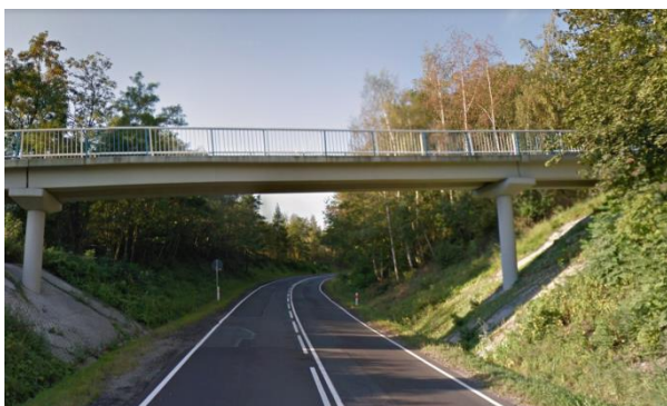
Fot. 13. Wiadukt nad DK nr 5 w km ok. 402+880
