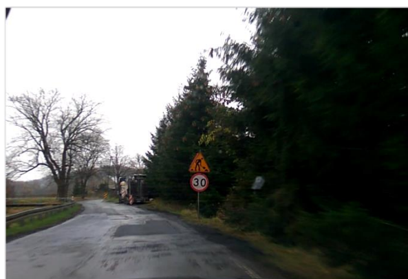
Fot. 30. Stan DW nr 375 w rejonie robót w Chwaliszowie
