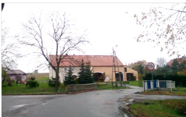
Fot. 53. Stan DP nr 2796D na moście w km ok. 005+180
