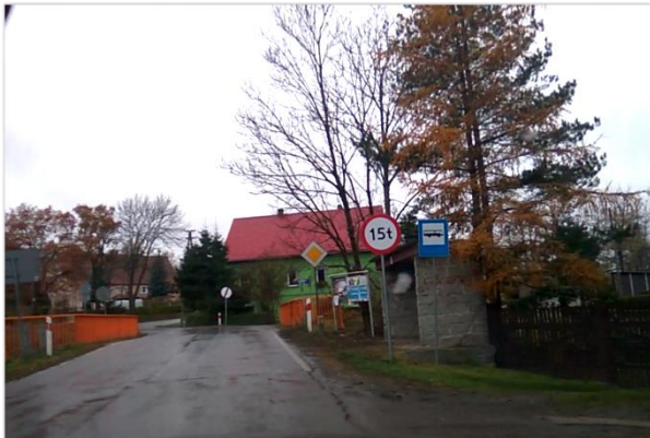
Fot. 31. Stan DW nr 375 w rejonie mostu na Strzegomce
