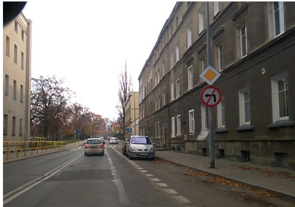
Fot. 8. Stan DK nr 34 na odcinku śródmiejskim
