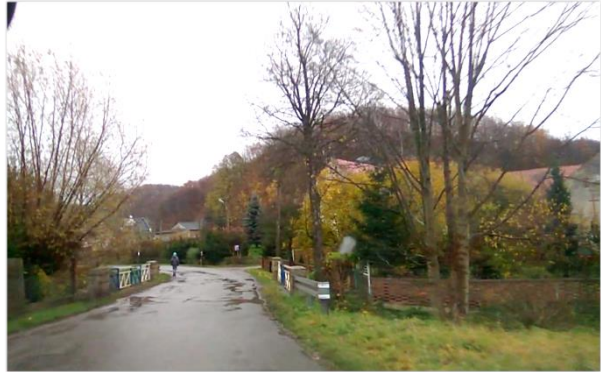
Fot. 56. Stan DP nr 2796D na moście w km ok. 003+590
