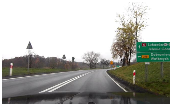
Fot. 14. Stan DK nr 5 w rejonie DW 375
