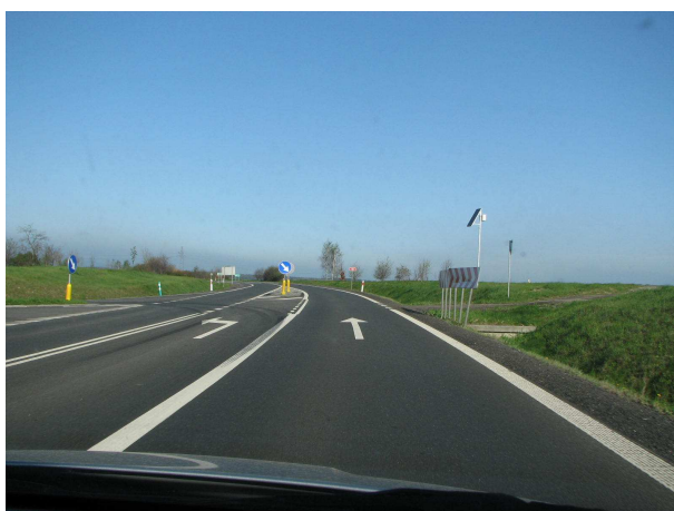
Fot. 7.2 Wydzielony pas dla relacji skrajnej na obwodnica Paczkowa w ciągu drogi krajowej nr 46 jako przykład odcinka zakwalifikowanego do kategorii dobrej.
