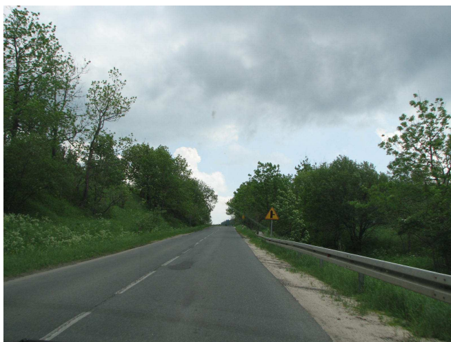
Fot. 7.11 Droga wojewódzka nr 367 w rejonie Przełęczy Kowarskiej. Na zdjęciu widać duże pochylenie podłużne jezdni.
