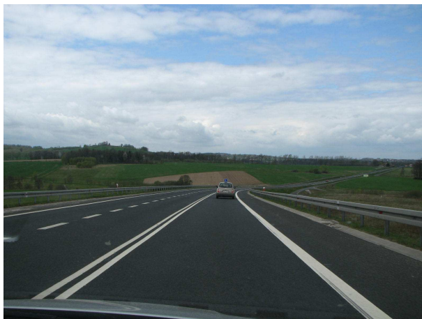
Fot. 7.1 Przekrój 2+1 na obwodnicy Radoniowa w ciągu drogi krajowej nr 30 jako przykład odcinka zakwalifikowanego do kategorii dobrej.
